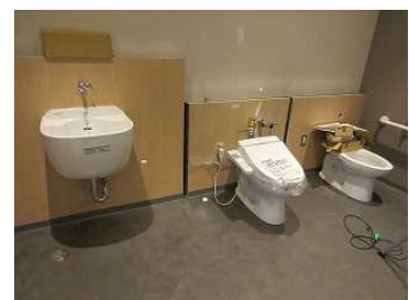
完成間近の洋式トイレ
